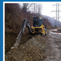
Работа по прокладке ВОЛС в горной местности
