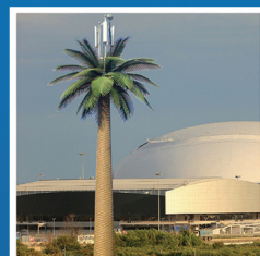
Базовая станция "Пальма"
